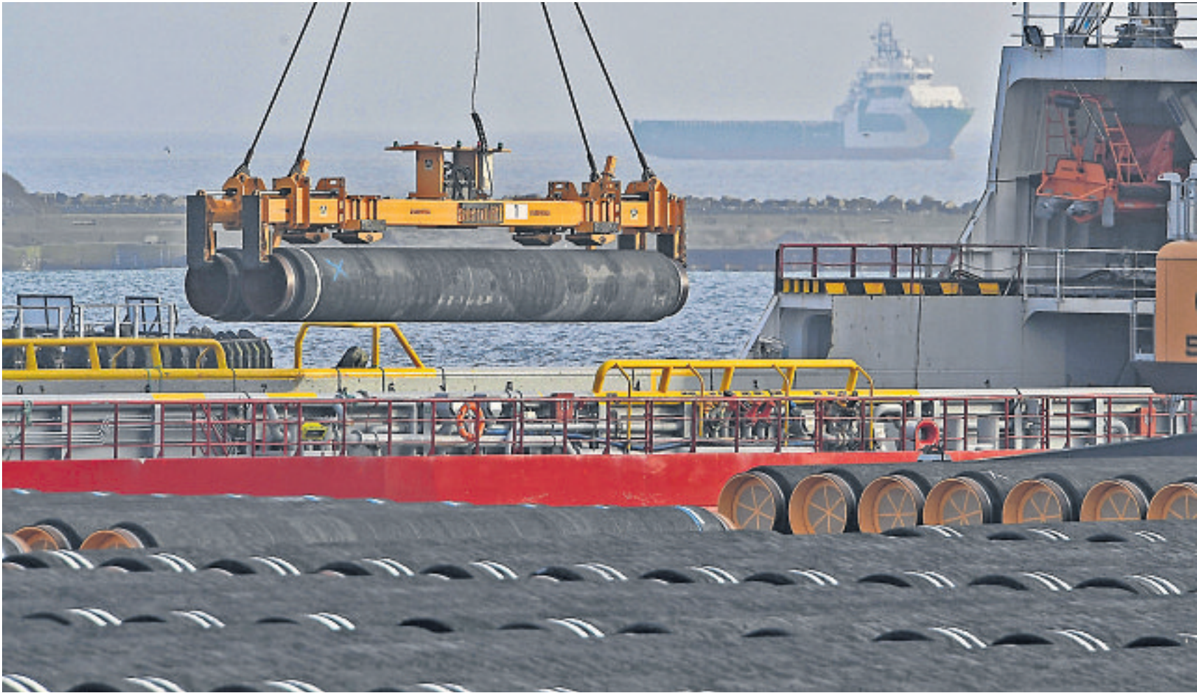
Pijpleidingen voor de Nord Stream 2 worden op een schip geladen.
