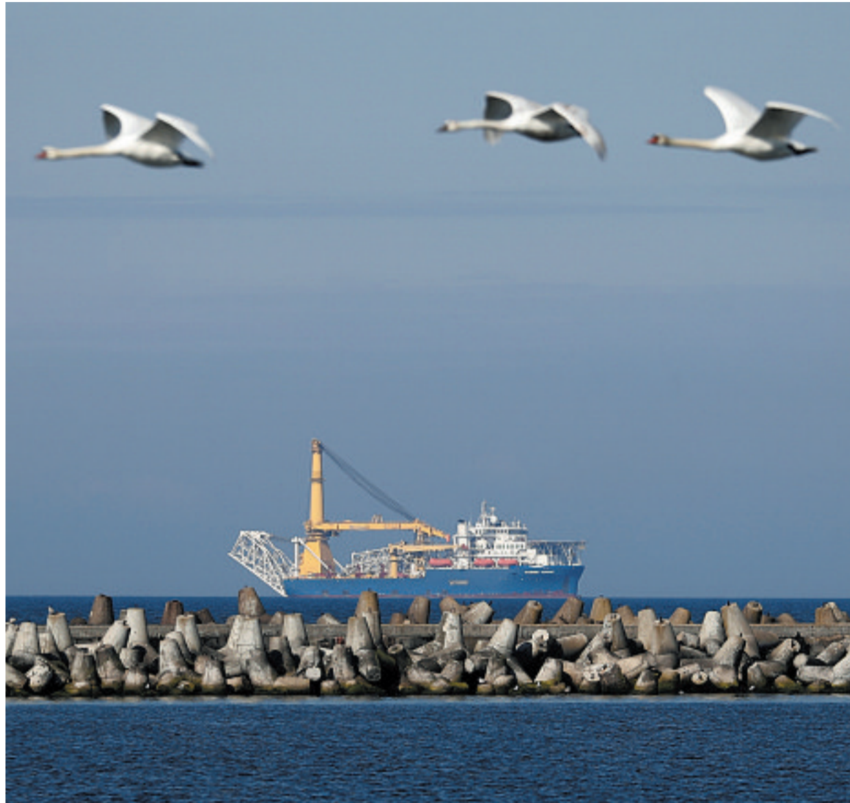
Gazprom-schip werkt aan de aanleg van de Nordstream 2-gaspijpleiding.
