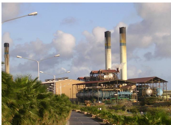
Foto 3.1 Aqualectra maakt elektriciteit en water op Mundo Nobo.
